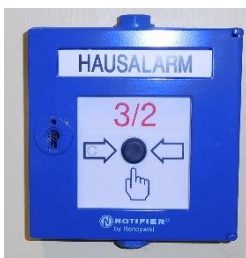
Druckknopfmelder für den Feuersalarm
